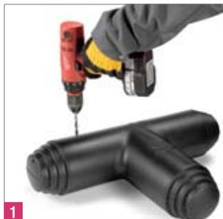
**1** Realizzare dei fori di sfiato sui lati utilizzando una punta a spirale da 3 mm e un foro per l'introduzione della schiuma di poliuretano espanso con una punta Forstner da 25 mm a seconda del diametro del tubo nel punto contrassegnato sulla diramazione.
