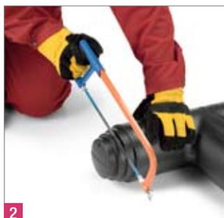
**2** Segare le estremità del manicotto in base alle dimensioni del tubo di rivestimento esterno RAUVITHERM da collegare (vedere le tacche).
