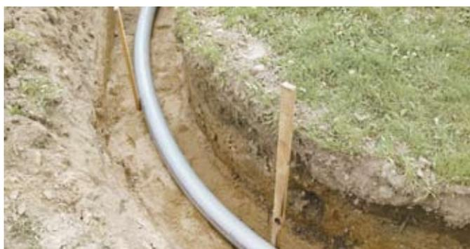
Fig. 46 Fissaggio in tratti curvi
