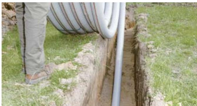
Fig. 45 Srotolamento della bobina
