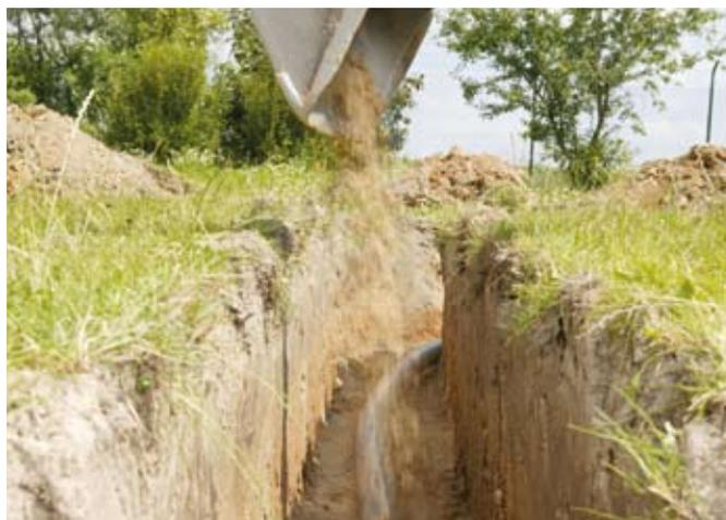
Fig. 49 Riempimento dello scavo con sabbia
