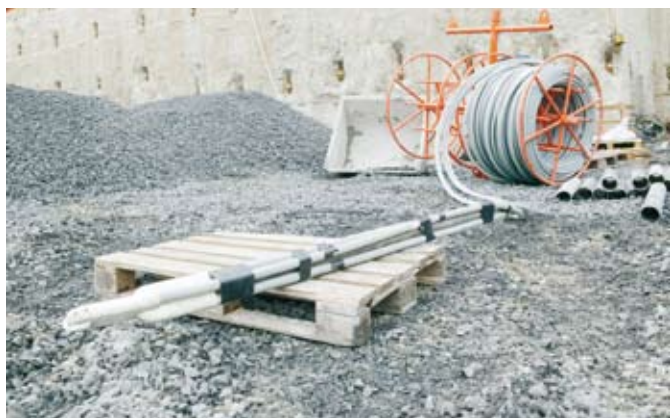
Fig.51: Controllo e preparazione della sonda
