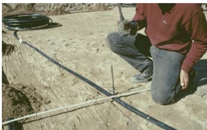
Fig.46: Posa del tubo e fissaggio
