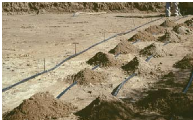
Fig.47: Copertura dei tubi con terra o sabbia
