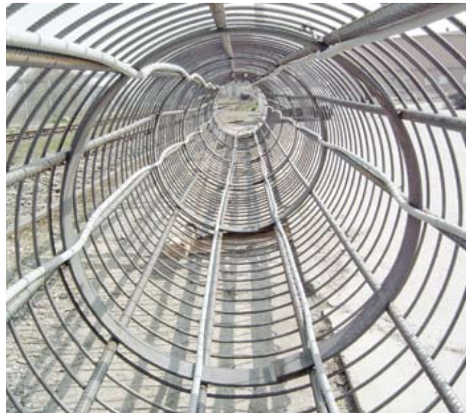
Fig.15: Pilastrino di fondazione con sonde integrate RAUGEO visto dall'interno
