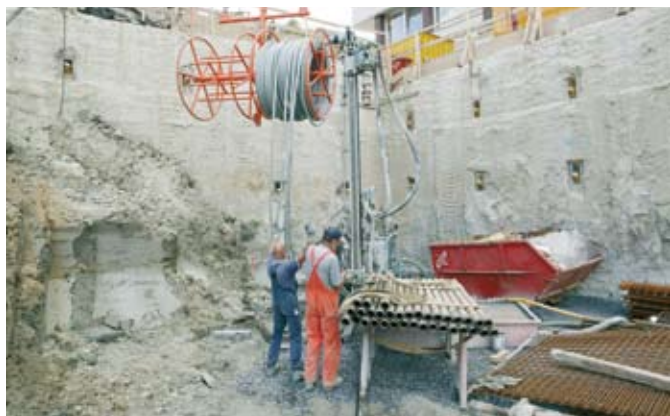
Fig.52: Preparazione della sonda
