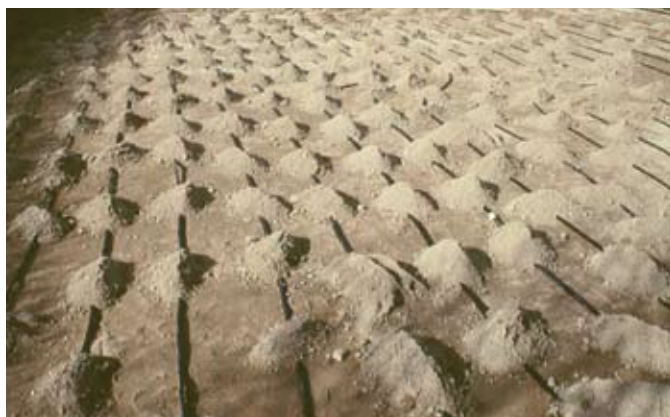
Fig.48: Riempimento e copertura delle tubazioni
