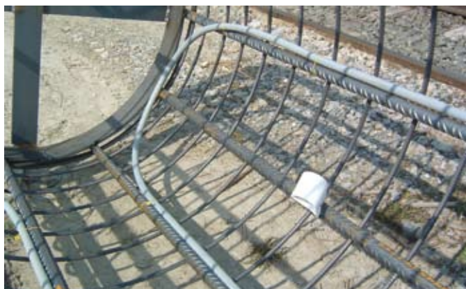
Fig.58: Montaggio dei tubi nell'armatura a gabbia.
