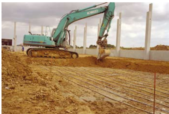
Fig.44: Posa in superficie
