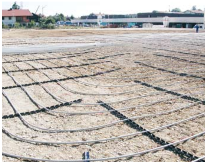
Fig.10: Posa del collettore RAUGEO collect PE-Xa
