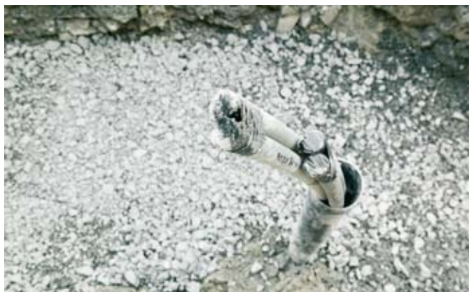
Fig.53: Inserimento nel foro di perforazione
