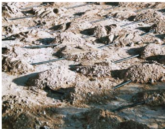
Fig.12: Posa del collettore RAUGEO collect PE 100
