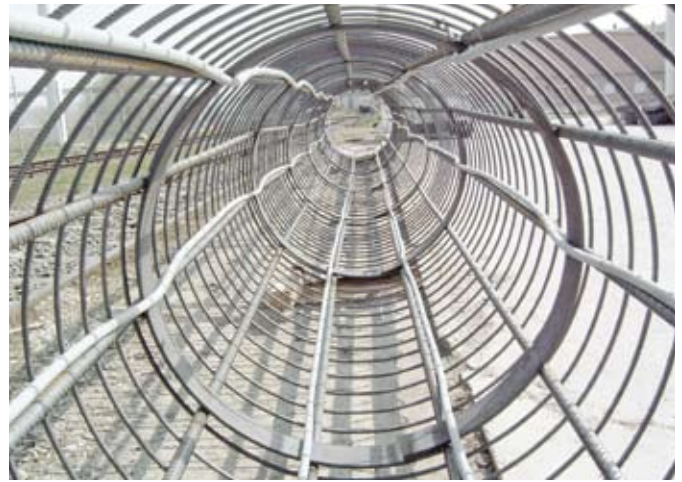
Fig.55: Posa dei tubi dei pilastri energetici
