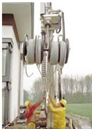
Fig.4: Applicazione di una sonda RAUGEO PE-Xa
