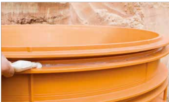
Fig. 5-25 Lubrificare la camera di tenuta superiore
