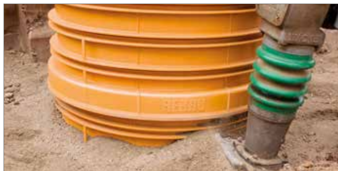
Fig. 5-30 Riempimento e impermeabilizzazione della zona pozzo.
