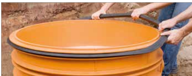
Fig. 5-26 Bloccaggio della tenuta elemento pozzo.
