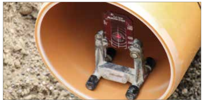
Fig. 5-11 Controllo pendenza tramite laser
