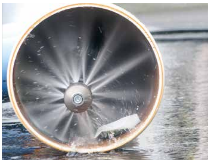
Fig. 6-2 Pulizia con acqua a pressione.
