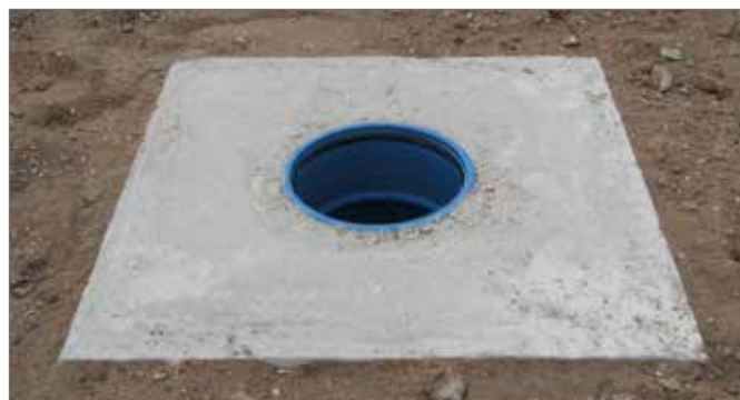
Fig. 5-1 Zoccolo in cemento con doppio manicotto a innesto
