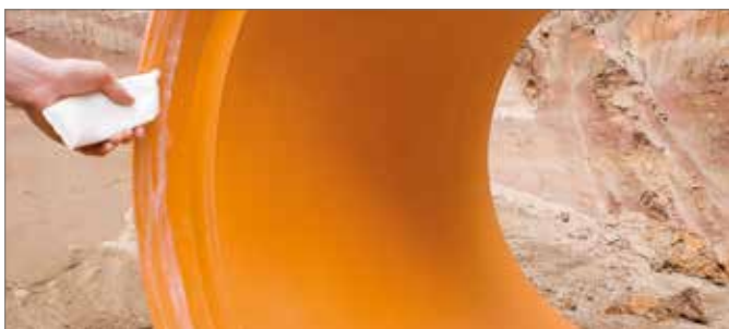
Fig. 5-28 Lubrificare uniformemente il manicotto dell'anello del pozzo.
