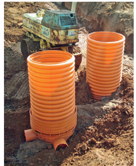
Abbildung 5: Inspektionsschächte DN 600: Als Hauskontroll-, End- und Durchgangsschächte eine kostengünstige Alternative zu DN 1000
