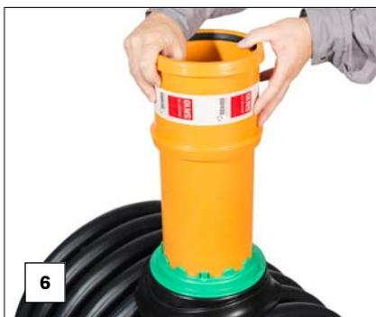
6. Das anzuschließende Rohr am Spitzende mit Gleitmittel versehen und bis zum Anschlag in die AWADOCK Einschraubkrone einstecken.
