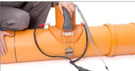
Schweißkabel am Anschweißsattel gewichtsentslastet anschließen, Schweißdaten z. B. mittels Barcode-Lesestift eingeben, die Anzeige am Schweißgerät überprüfen und Schweißvorgang durchführen.
