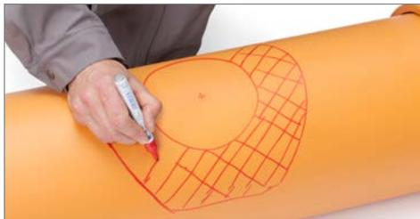
2. Den Anschweißsattel an der vorgesehenen Stelle auf dem Rohr positionieren, die äußere Kontur und die innere Kontur des Sattels nachzeichnen sowie den Mittelpunkt des Sattelabgangs markieren.
