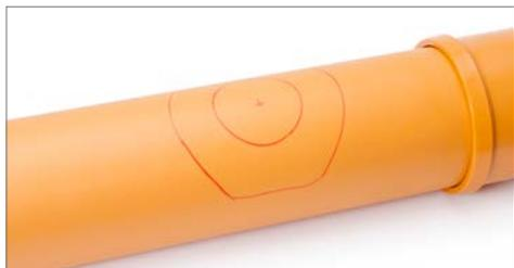
5. Unmittelbar vor der Verschweißung die Oxidschicht von den Rohroberfläche im Schweißbereich mit einem Handschaber vollständig entfernen. Die Markierungs-Kontrollstriche (Schraffur) müssen nach dem Schaben komplett entfernt sein. Späne sind zu entfernen.
