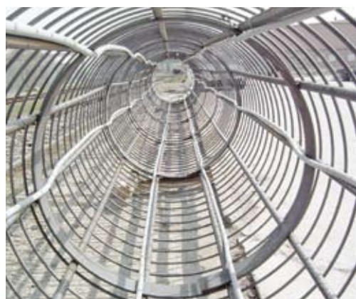
Pilastro di fondazione prima della posa
