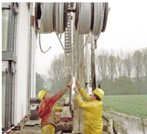
Installazione di una sonda geotermica RAUGEO
