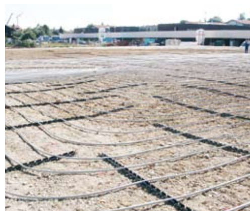
Posa dei collettori geotermici RAUGEO
