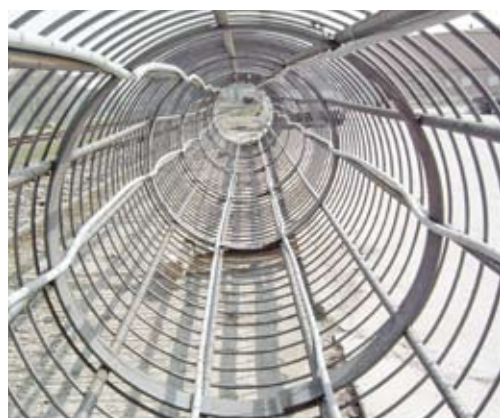
Pilastro di fondazione prima della posa
