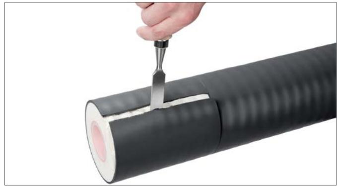
Entfernen Sie den PU-Schaum im Bereich des abgeschälten Mantelrohres.
