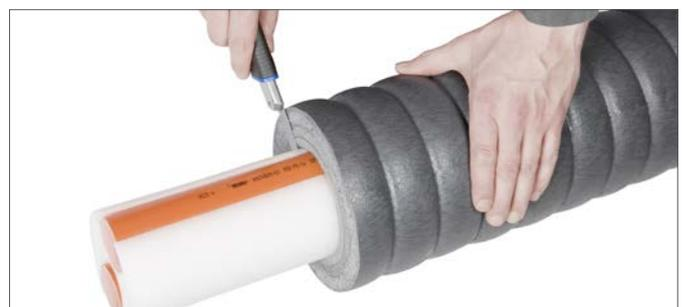
Entfernen Sie die Dämmplatten und bei DUO Rohren zusätzlich den Schaum- knochen.
