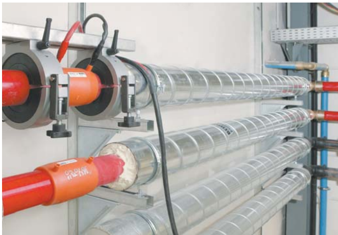
Abb. 46: Verbindungsherstellung mit Universalrohrhalteklammer
