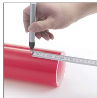
Abb. 09: Abschabbereich gemäß folgender Tabelle anzeichnen. Stift in Kontrastfarbe verwenden.
