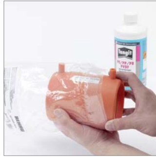
Abb. 14: FUSAPEX-Elektroschweißmuffe erst jetzt dem Beutel entnehmen. Wenn erforderlich Schweißmuffe mit Tangit säubern.
