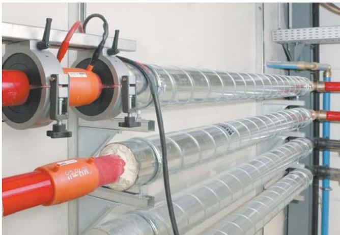
Abb. 46: Verbindungsherstellung mit Universalrohrhalteklammer
