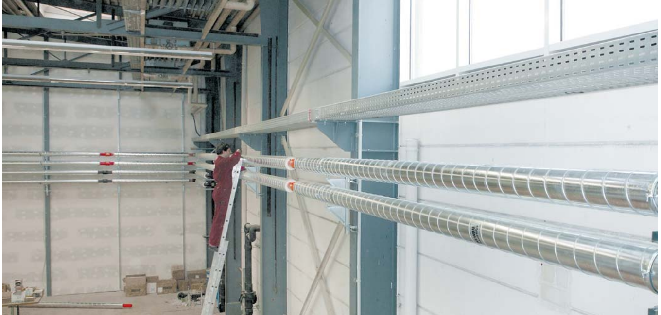
Abb. 45: FUSAPEX-Installation (Rohrtyp RAUFRIGO-FW vorisoliert, Rohrlänge 6 m, Stützweite 5 m)
