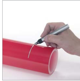
Abb. 29: Zum Anzeichnen Stift in Kontrastfarbe zum Rohr verwenden.
