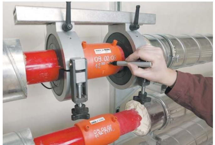
Kennzeichnung der Elektroschweißmuffe FUSAPEX
