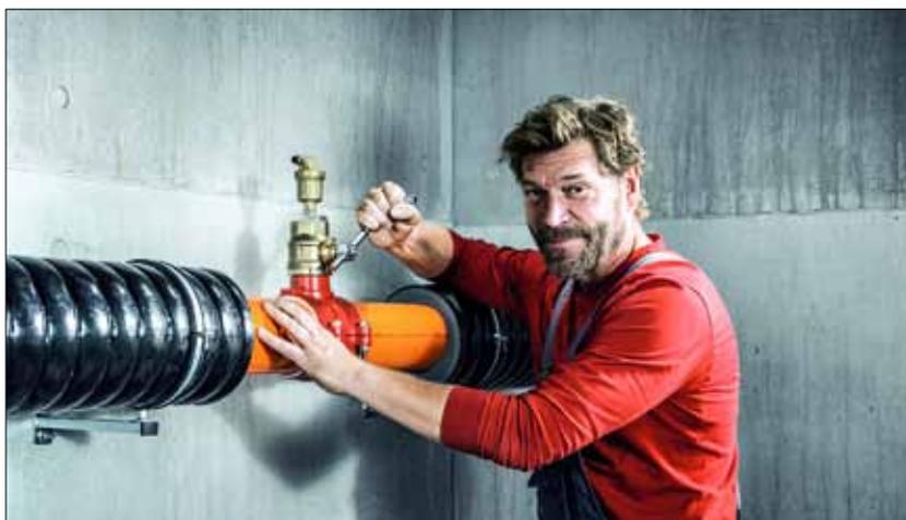
Bild 1. Anbohrvorgang mit der Armatur Nexus
