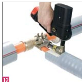
**12** Pour créer un piquage, sertissez le troisième tube. Si nécessaire, découpez une encoche pour permettre le passage de l'outil de sertissage. Une fois ces étapes effectuées, le raccordement du tube est terminé.
