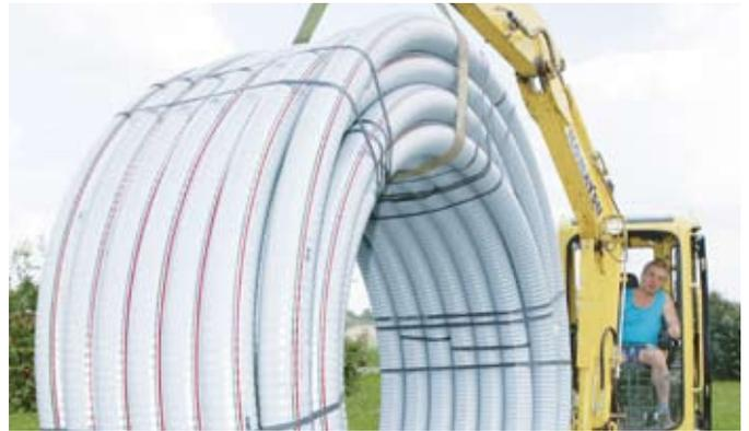
Fig. 5.3 - Préhension avec pelle excavatrice
