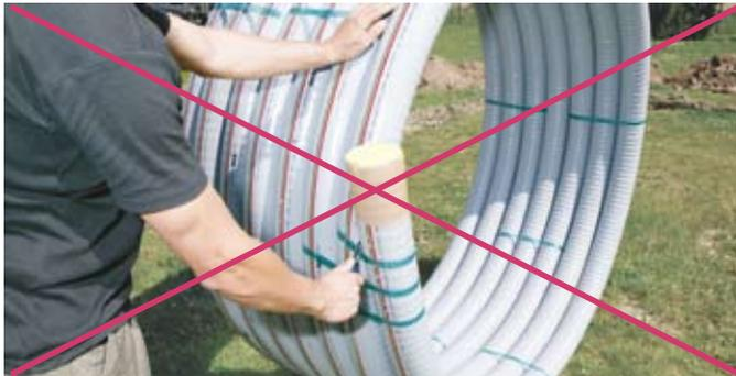
Fig. 5.7 - Tranchage des bandes de maintien des anneaux de la couronne
