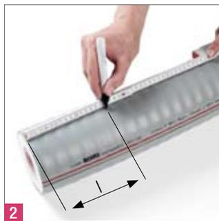
**2** Repérez la longueur à dénuder en fonction du diamètre extérieur du tube du caloporteur.
