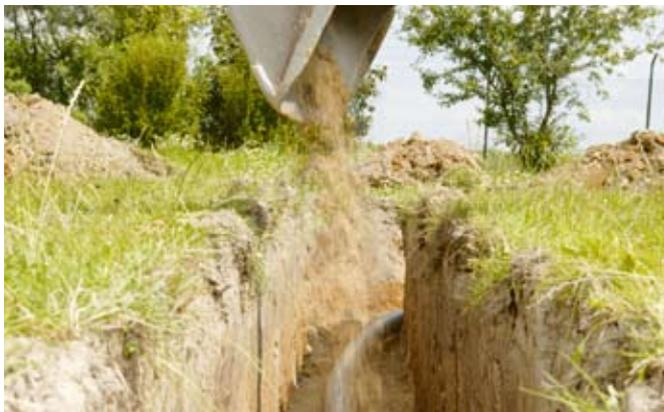
Fig. 5.12 - Remblayage de la tranchée avec du sable
