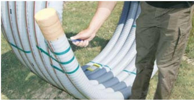
Fig. 5.6 - Tranchage des bandes de maintien de la couronne
