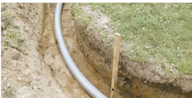
Fig. 5.10 - Détermination de la zone de courbure
