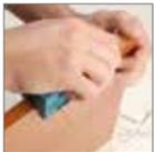
6.- Proceder al refilado utilizando un refilador manual.
