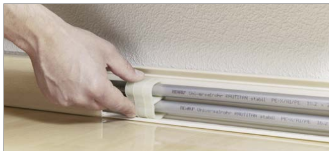
Obr. 18-30 Zasuť držiaka vykurovacej rúrky
