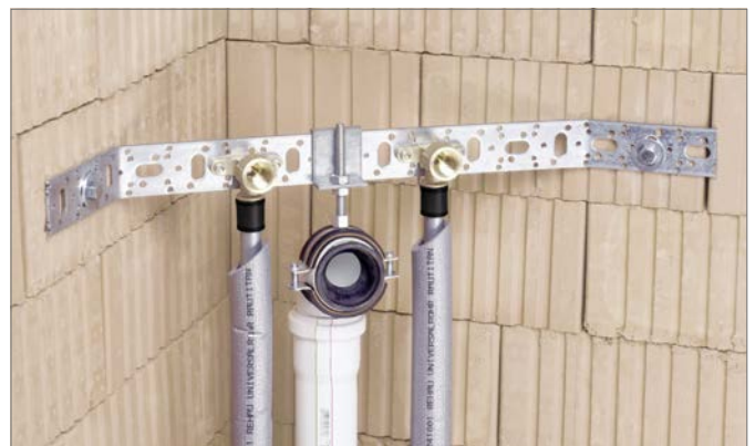
Obr. 5-3 Príklad zabudovania montážnej lišty
