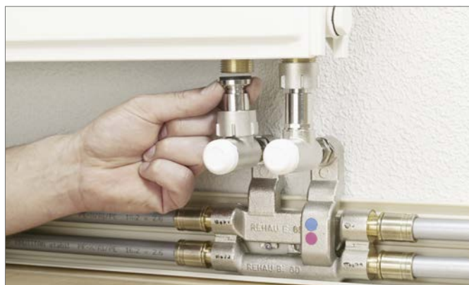
Obr. 18-22 Pripojenie sady teleskopických rohových prípojok REHAU
