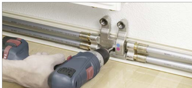
Obr. 18-29 Upevnenie SL krížového kusu RAUTITAN
