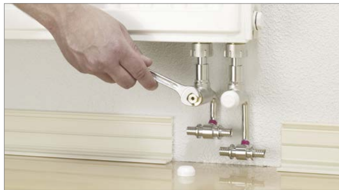
Obr. 18-39 Pevné dotiahnutie svorného skrutkovania
