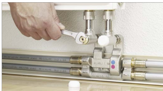
Obr. 18-32 Pevné dotiahnutie svorného skrutkovania
