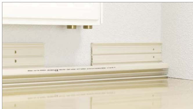
Obr. 18-37 Namontovaná spodná časť kanála soklovej lišty RAUDUO s vyhlbením
