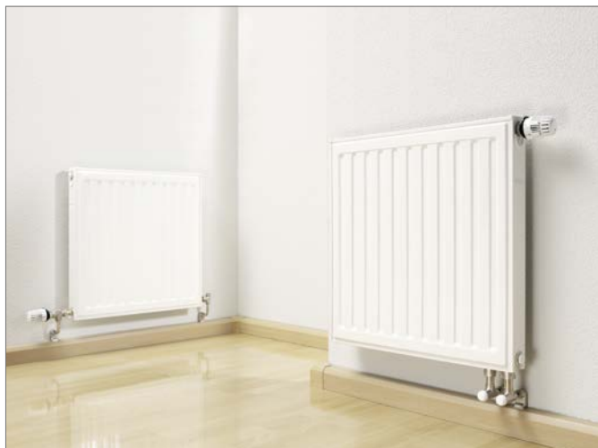
Obr. 18-1 Pripojovací systém vykurovacieho telesa v soklovej lište
