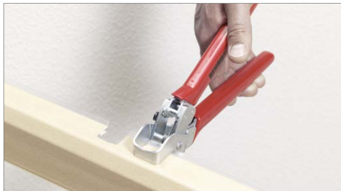
Obr. 18-33 Vysekávanie hornej časti kanála soklovej lišty
