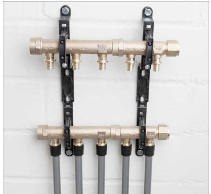
Obr. 17-11 Sanitárny rozdeľovač pomocou násuvných objímok
