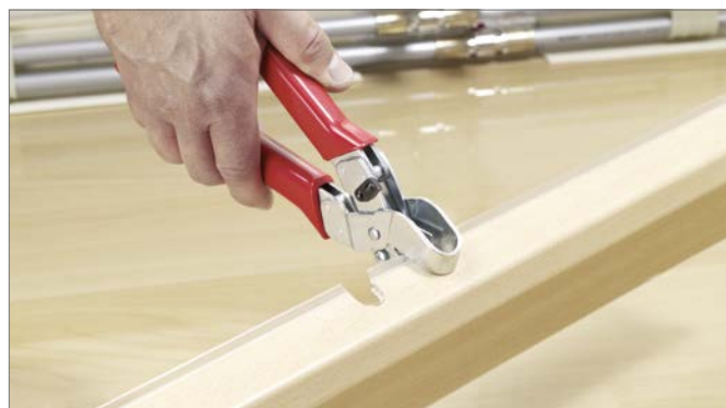
Obr. 18-40 Vysekávanie hornej časti kanála soklovej lišty
