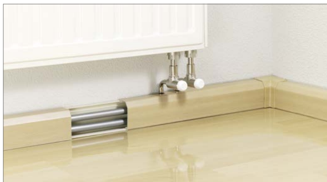
16-44. ábra Felszerelt RAUSOLO falszegély csatorna RAUTITAN SL csatlakozó garnitúrával
