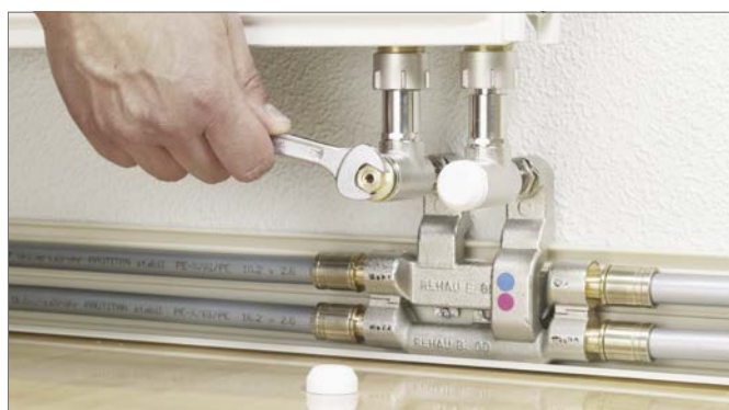
16-38. ábra A szorítógyűrűs csavarzat meghúzása
