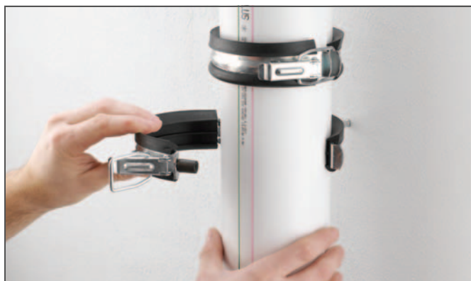
6-2. ábra A támasztóbilincs bezárása
