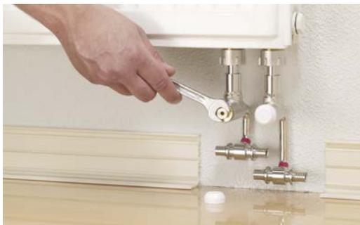
Fig. 18-12 Serrer le raccord à visser
