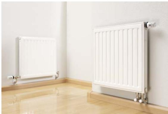
Fig. 18-1 Raccordement au radiateur depuis la plinthe
