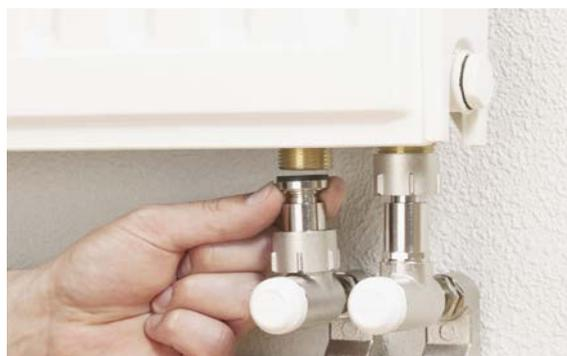
Fig. 18-8 Jeu de vannes équerres télescopiques
