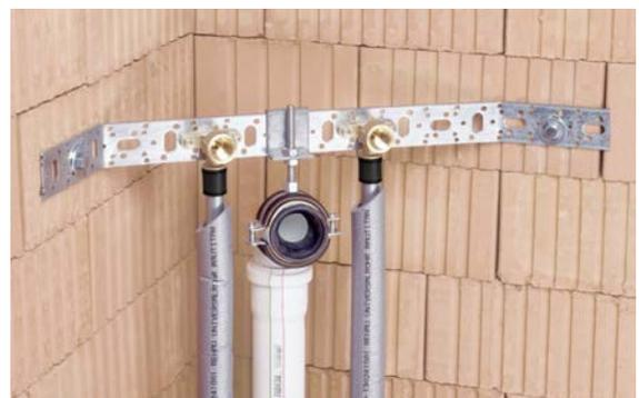
Fig. 06-3 Exemple d'installation du rail de montage
