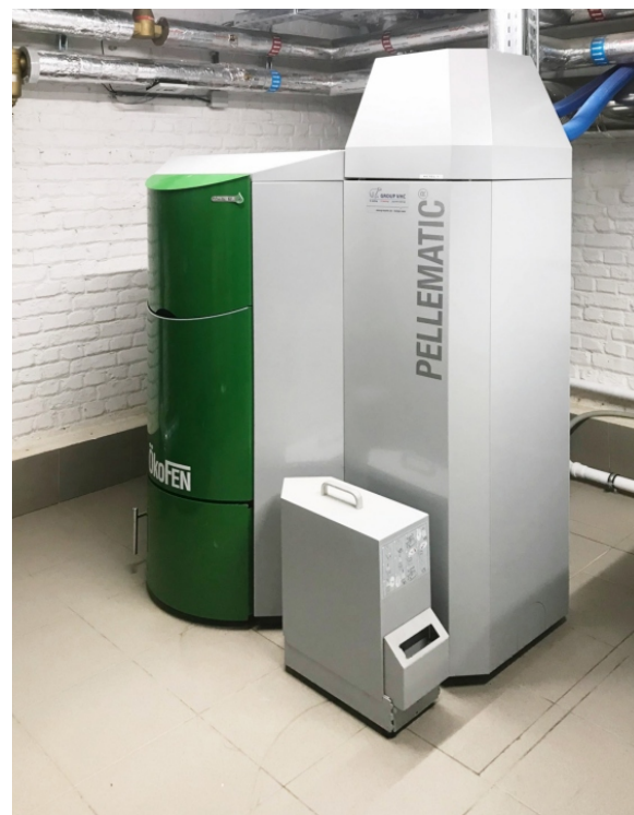
Lors de la recherche d'une solution de chauffage adéquate, les pompes à chaleur individuelles ont été exclues à cause du coût et de l'esthétisme. Une chaufferie centrale avec deux chaudières à pellets s'est avérée plus appropriée
