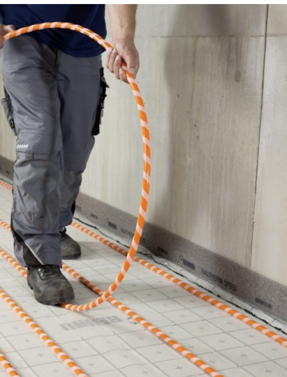
Grâce à la bande autoagrippante, l'isolation (acoustique) n'est pas perforée et on peut travailler plus vite
