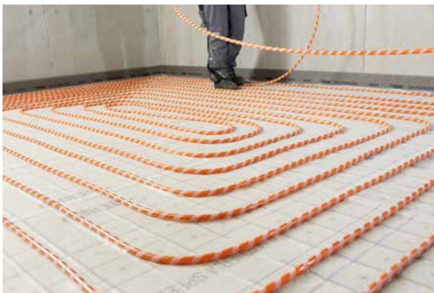
La fixation auto-agrippante évite de devoir percer la couche d'isolation acoustique, ce qui fournit un meilleur confort acoustique. (Photo: REHAU)
