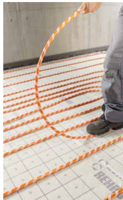
La fixation via un tapis auto-agrippant est une particularité du système. (Photo: REHAU)
