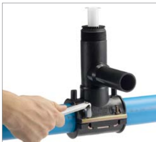
56. ábra 4. A megfúró bilincs rögzítése.
