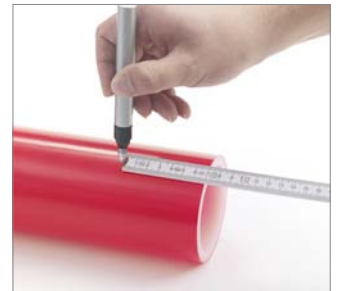
91. ábra Rajzolja be a hántolási területet a következő táblázat szerint! A cső színétől elütő színű filctollat használjon!
