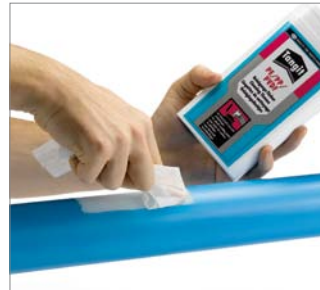
55. ábra 3. A hegesztési zónának zsír- és pormentesnek kell lennie. Szükség esetén Tangit oldattal tisztítsa meg a felületet, majd hagyja teljesen elpárologni!
