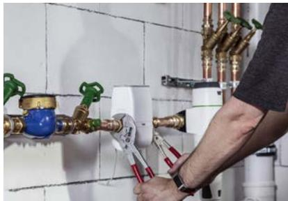
Hacer que un profesional instale el control para tuberías de agua RE.GUARD junto al contador y preconectado al filtro. ¡Listo!
