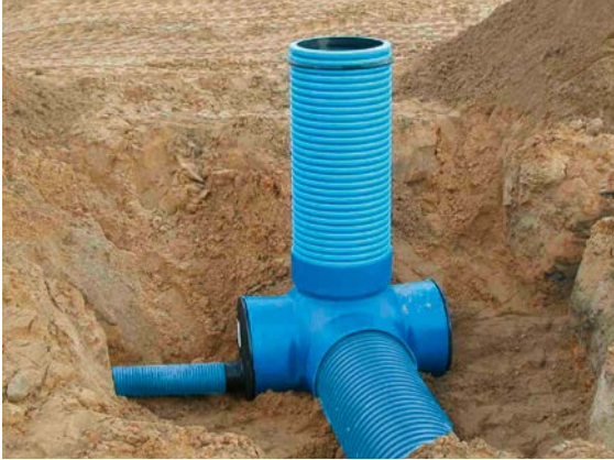
Eingebauter RAUSIKKO Universalschacht
