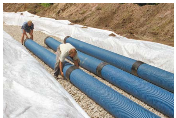
Rohre mittels Doppelsteckmuffen verbinden
