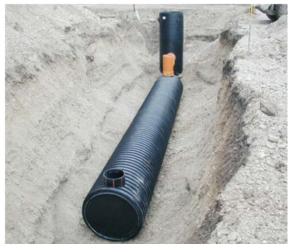
RAUSIKKO SediClean Typ M/R vor der Verfüllung
