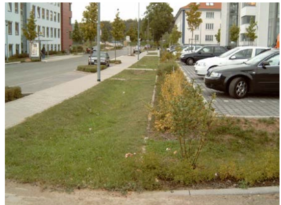
Versickerungsmulde einer Mulden-Rigole nach Fertigstellung
