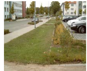
Versickerungsmulde einer Mulden-Rigole nach Fertigstellung
