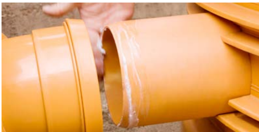
Aufbringen des Gleitmittels
