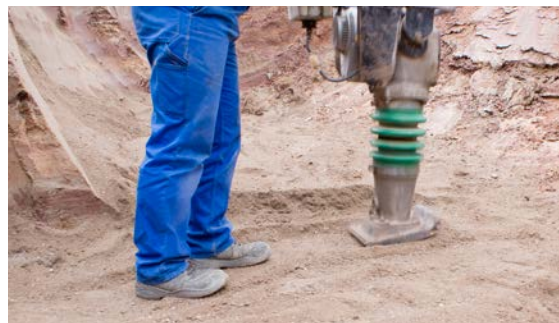
Herstellen des Schachtauflagers
