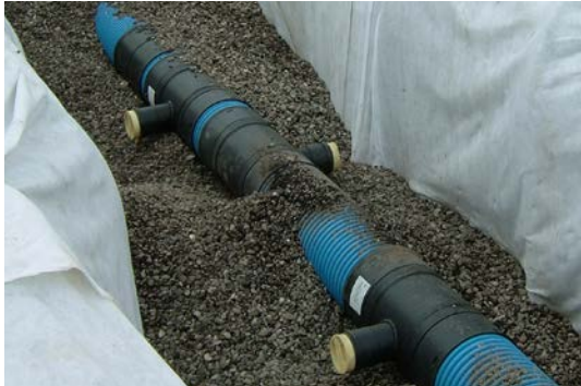
Leitungszone mit Rigolenkies verfüllen
