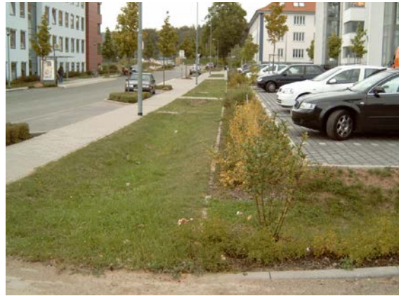
Versickerungsmulde einer Mulden-Rigole nach Fertigstellung
