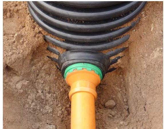
Anschluss der Entlüftung an die Schachtverlängerung mittels AWADOCK
