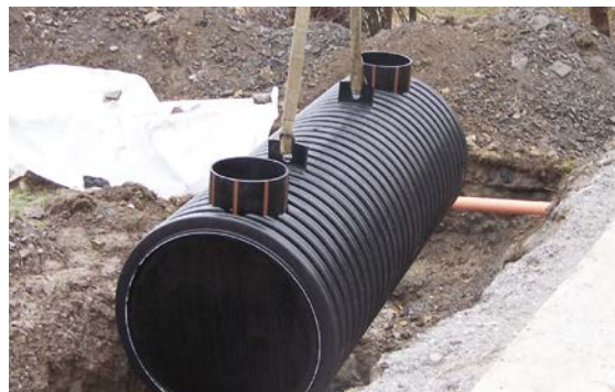
Ablassen des Sedimentationsmodules in den Rohrgraben
