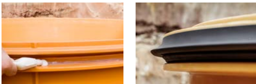
Aufbringen des Gleitmittels Eingelegter Dichtring
