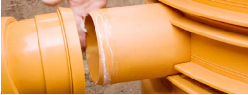
Aufbringen des Gleitmittels
