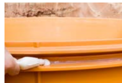
Aufbringen des Gleitmittels
