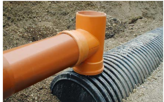
Anschluss der Zuleitung an das drehbare Zulaufteil
