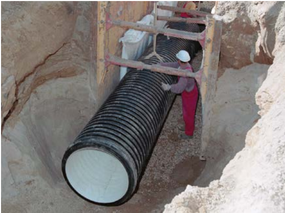
Verlegung eines RAUVIA Special Rohres
