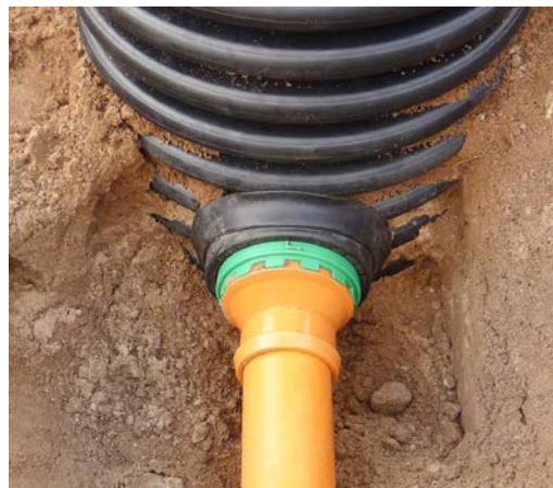
Anschluss der Entlüftung an die Schachtverlängerung mittels AWADOCK
