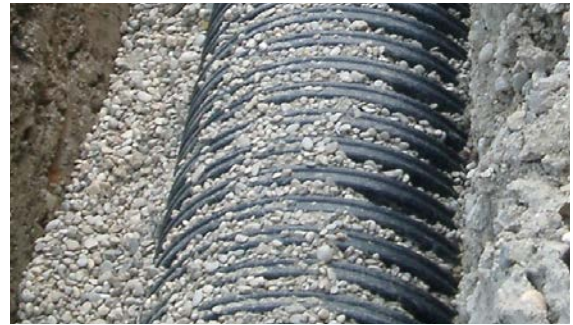
Verfüllung in der Leitungszone
