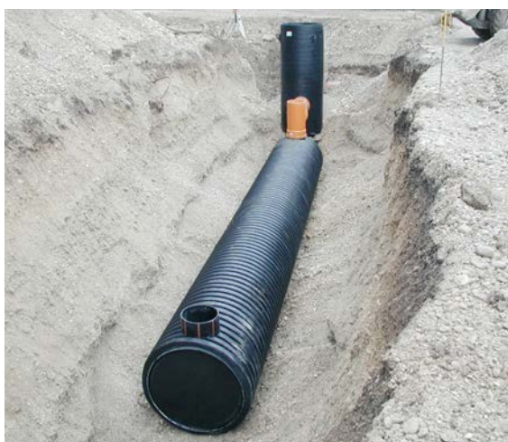
RAUSIKKO SediClean vor der Verfüllung
