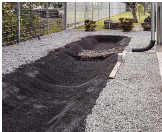
Versickerungsmulde nach Einbau des PURAT 200
