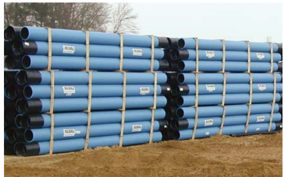
Lagerung der RAUSIKKO Rohre
