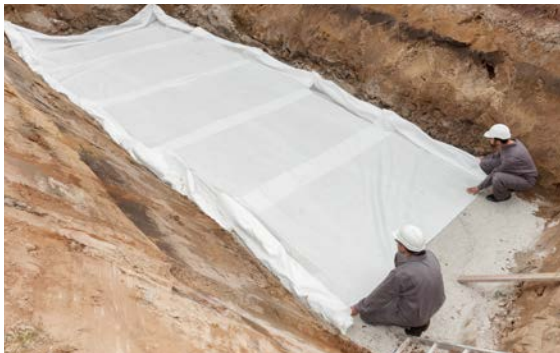
Baugrube mit ausgelegter Vliesbahn
