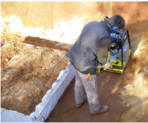
Verdichten des Arbeitsraumes
