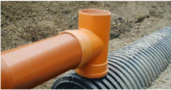
Anschluss der Zuleitung an das drehbare Zulaufteil
