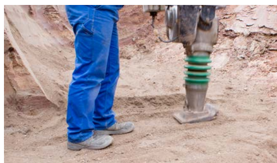
Herstellen des Schachtauflagers
