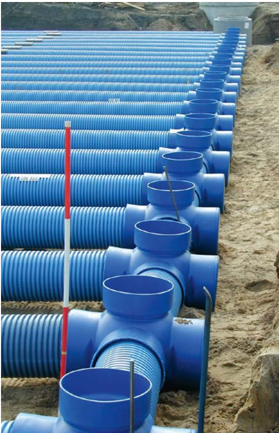
Schachtunterteile des RAUSIKKO Universalschachtes
