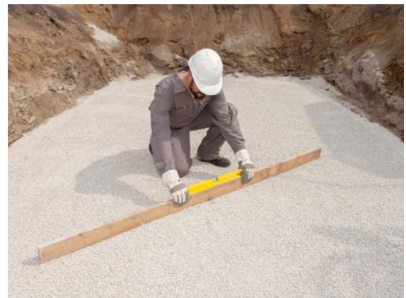
Abziehen des Splitt-Auflagers
