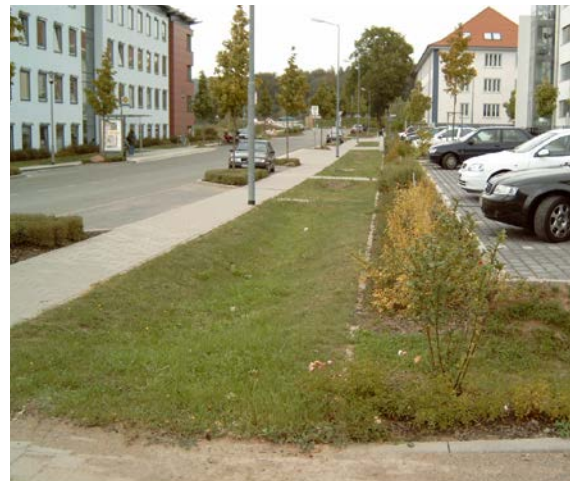
Versickerungsmulde einer Mulden-Rigole nach Fertigstellung
