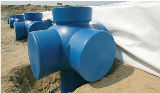
Vertiefung der Grabensohle für das Universalschacht-Unterteil
