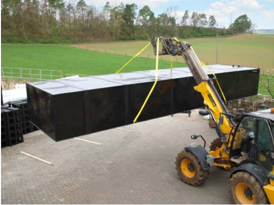
Transport eines Speichermoduls mit den mitgelieferten Hebegurten
