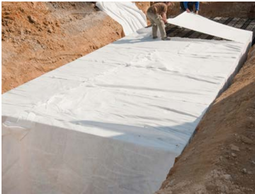
RAUSIKKO Box-Rigole mit Filtervlies RAUMAT
