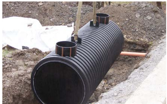
Ablassen der Sedimentationsstrecke in den Rohrgraben
