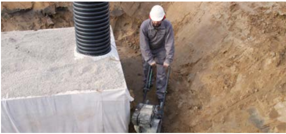
Verdichten des Arbeitsraumes
