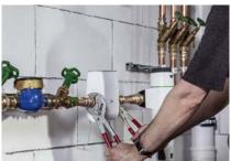
Confier à un professionnel la pose du module de contrôle de l'eau RE.GUARD après le compteur d'eau et avant le filtre d'eau domestique. Terminé!
