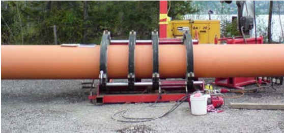
Heizelementstumpfschweißen
