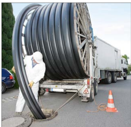
Rohrsanierung mit U-Liner
