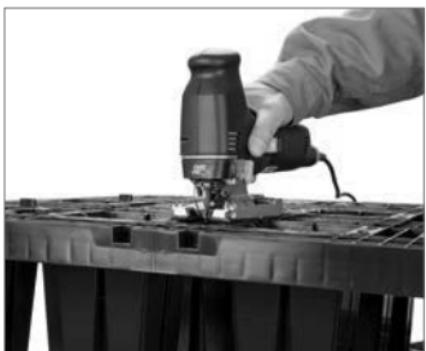
Découpe d'un élément en suivant le guide
