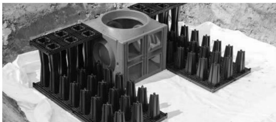
Erste Schritte des Aufbaus der Rigole mit Spülkanal im Mauerwerksverbund
