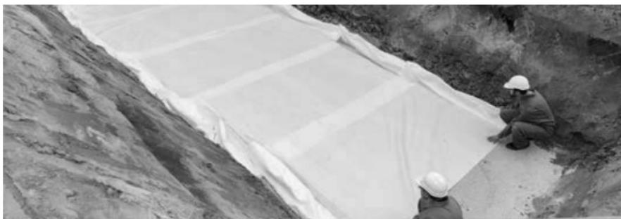
*Scavo con il telo geotessile steso*
