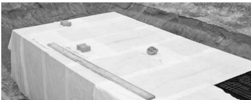
*RAUSIKKO Box zariadenie obalené filtračnou geotextíliou*
