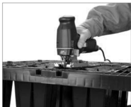
Zerteilen des Grundelementes entlang der Schnittmarkierung
