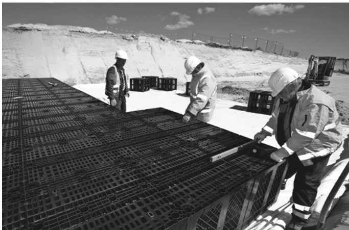
Montaż skrzynek RAUSIKKO Box
