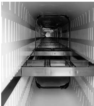
Vyplachovací a rozváděcí kanál RAUSIKKO boxu
