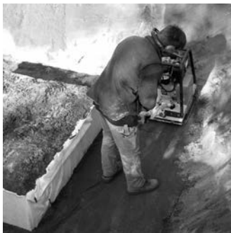
Compattamento dell'area di lavoro
