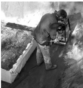
Zagęszczanie obszaru roboczego
