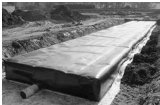
Bassin de rétention avec géomembrane
