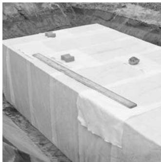
Bacino a elementi modulari RAUSIKKO con filtro geotessile in tessuto non tessuto RAUMAT
