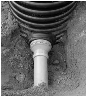
Rallonge du regard RAUSIKKO C3 avec le tuyau de raccordement AWADOCK type B DN 160
