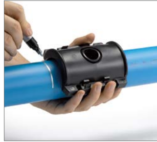
Abb. 53 1. Anbohrschellenunterteil an gewünschter Position anlegen und anzeichnen.
