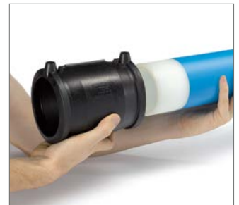
Abb. 45 7. Elektroschweißmuffe vollständig auf das erste Rohrende aufschieben.
