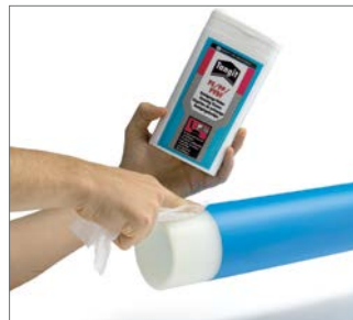
Abb. 43 5. Abschabbereich muss staub- und fettfrei sein. Mit ausreichend Tangit-Reiniger säubern und komplett verdunsten lassen.
