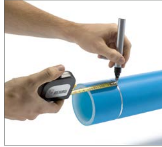
Abb. 40 2. Das Abschabmaß gemäß Tabelle 8 anzeichnen.
