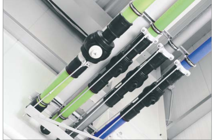
Abb. 94 Zugvorrichtung und Festpunktconstruction im Objekt Winkelmann GmbH + Co. KG
