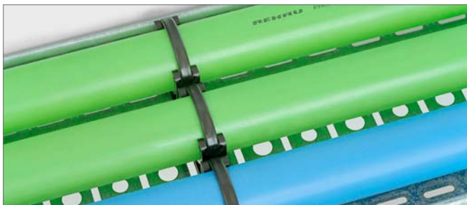
Abb. 84 RAUPEX-Rohre im Kabelträgersystem verlegt
