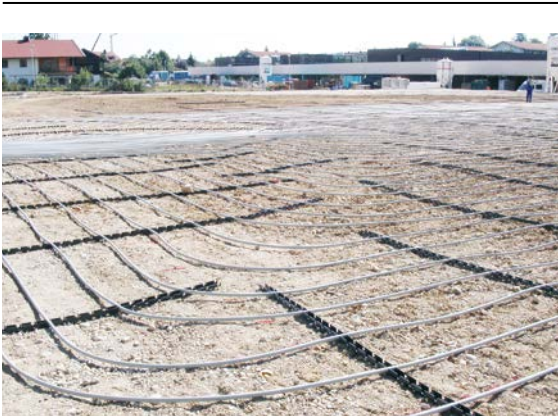
Abb. 05-2 Flächenverlegung
