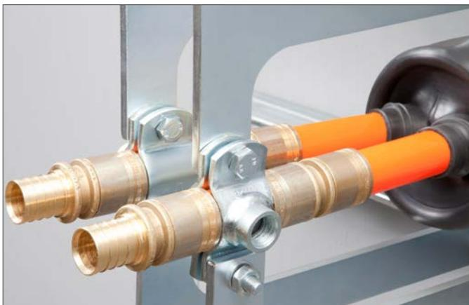
Abb. 6: Fixierung der Mediumrohre am Hausanschluss
