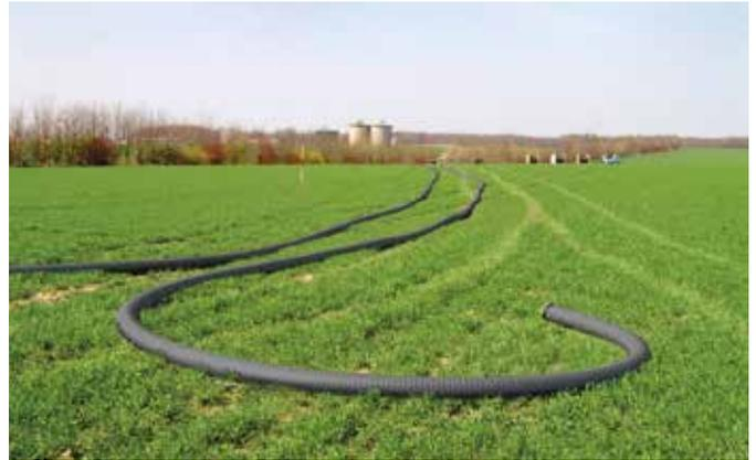
Abb. 55 Nahwärmeröhre
