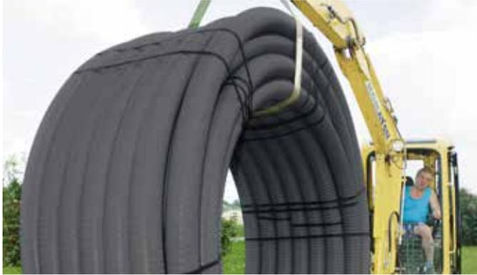
Abb. 47 Aufnehmen mit dem Bagger
