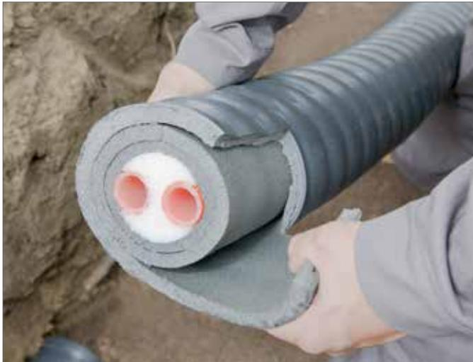
Abb. 9 Abisolieren des Rohres
