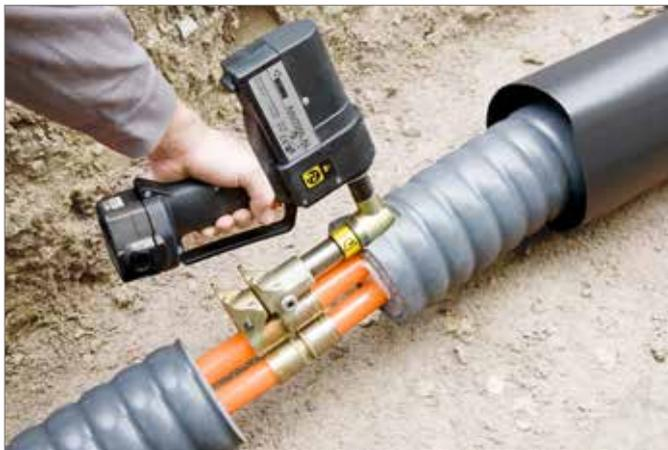
Abb. 2 RAUVITHERM Schiebehülsenverbindung
