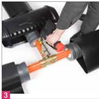
Verbinden Sie die Mediumrohre (siehe 5.3 Rohrverbindung, Punkt 7 ff.).
