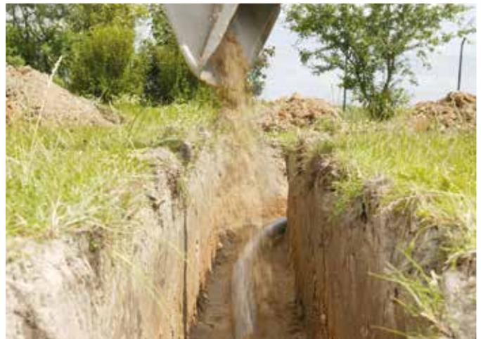
Abb. 56 Rohrgraben mit Sand füllen
