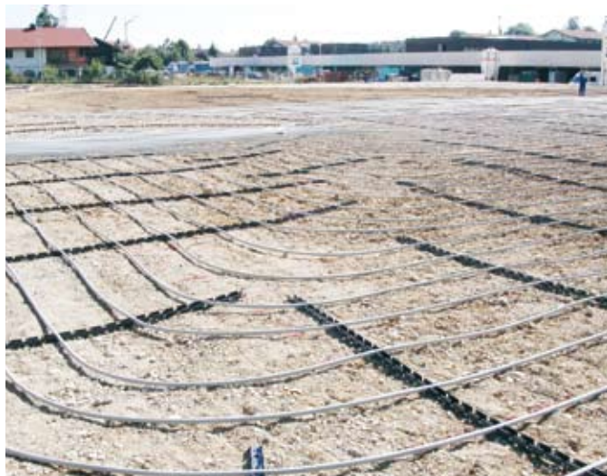
Obr. 10: Položení RAUGEO collect PE-Xa
