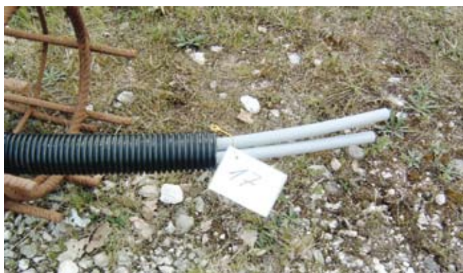
Obr. 59: Spojení přítoku a vratného toku v chráničce
