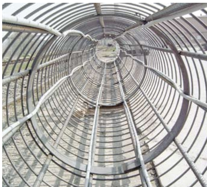
Obr. 15: Trubky RAUGEO collect PE-Xa montované v armovacím koši
