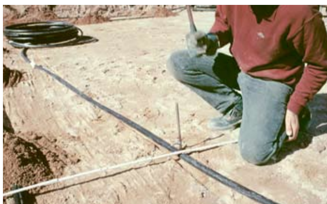
Obr. 46: Položení a upevnění potrubí
