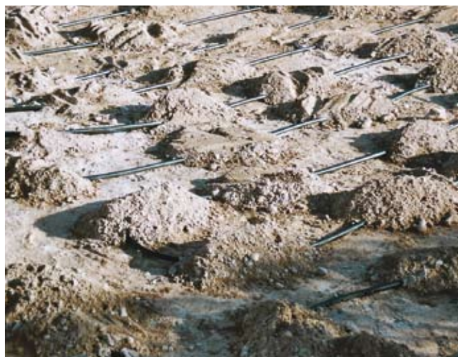
Obr. 12: Pokládání RAUGEO collect PE 100
