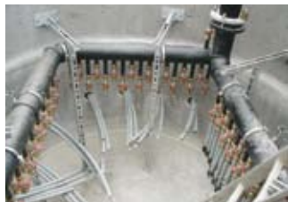
Obr. 63: Plastový rozdělovač
