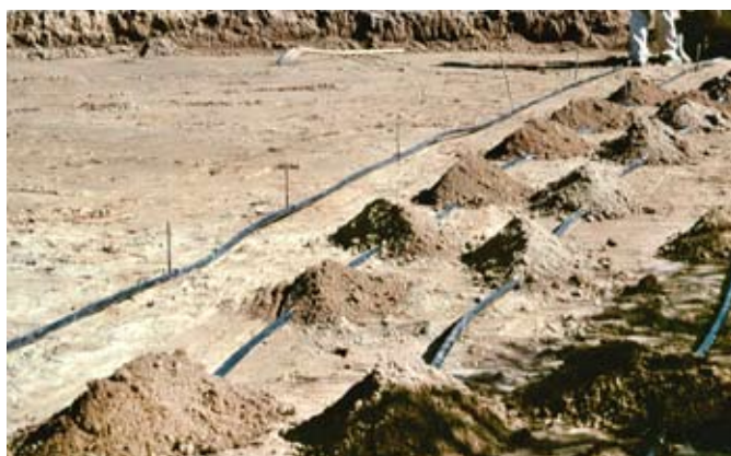
Obr. 47: Zakrytí trubek zeminou nebo pískem
