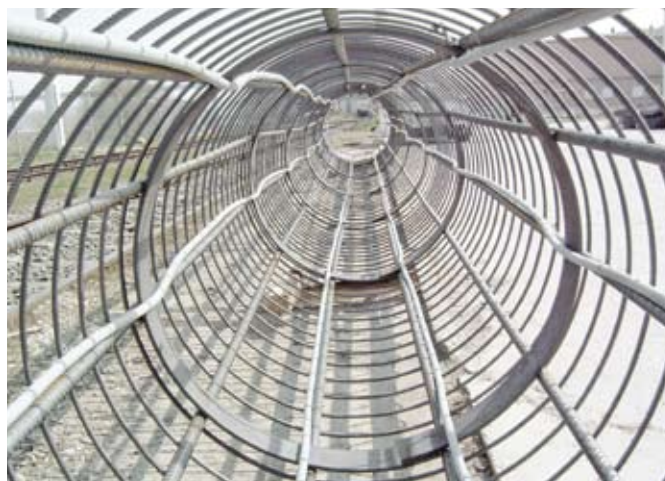
Obr. 55: Pokládání trubek energetické piloty
