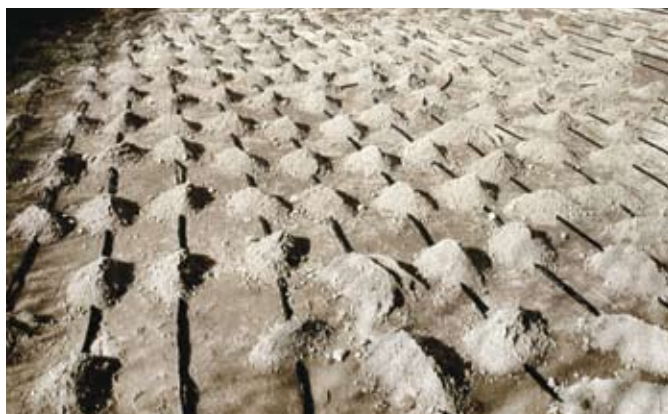
Obr. 48: Pokrytí a zakrytí potrubí
