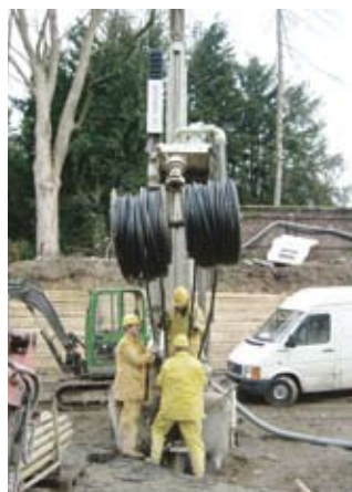
Obr. 7: Ukládání sondy RAUGEO PE 100
