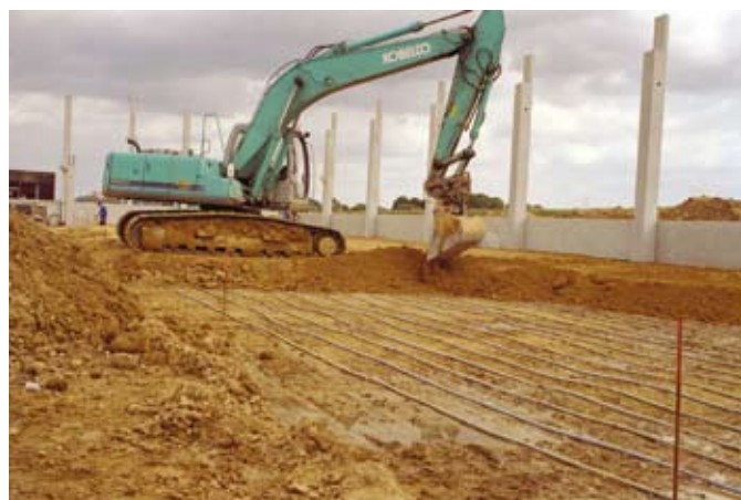
Obr. 44: Plošné pokládání
