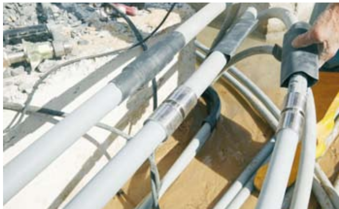
Obr. 54 Spojení s přípojovacím vedením
