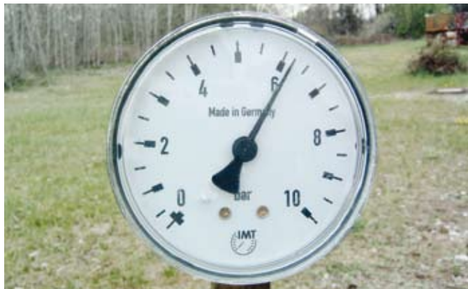
Obr. 61: Tlaková zkouška při 6 barech
