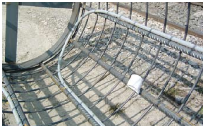
Obr. 58: Montáž potrubí na armovací koš
