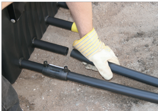
Obr.9 Připojení PE trubek
