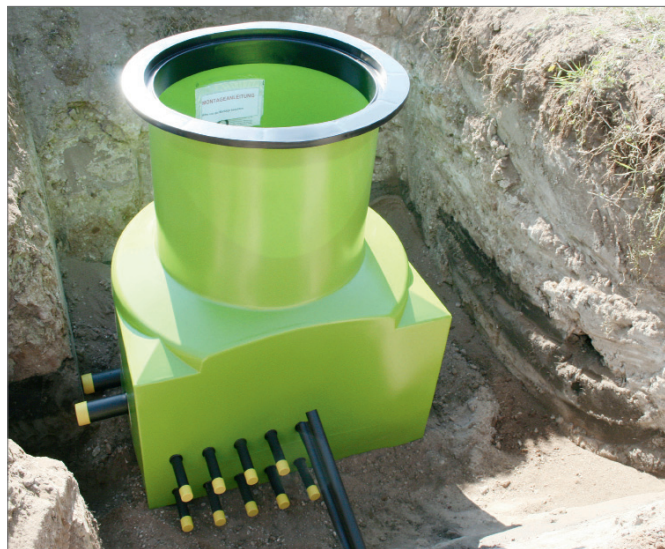
Abb. 12 Uložení šachty rozdělovače midi
