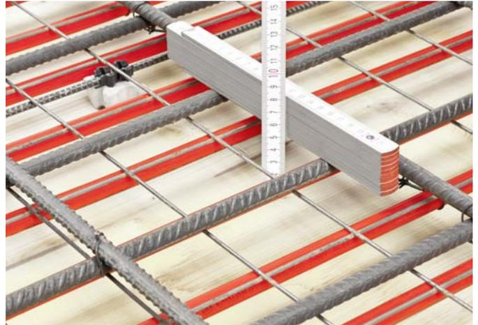
Messen des Achsabstand  $u \geq 37 \text{ mm} + 1/2 d$  ( $d$ = Durchmesserbewehrung)
