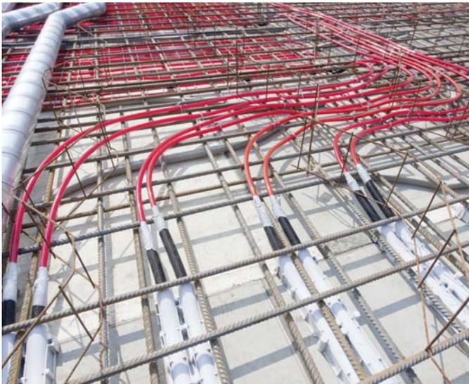
Anbindeleitung in den Schalungskasten geführt und abgedichtet
