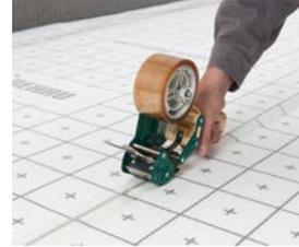
4 Alle Überlappungen der Plattenlängskanten und alle Querkanten mit REHAU Klebeband verkleben.
