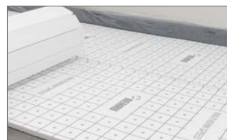
3. Längsseitiger Folienüberstand weiterer Platten überlappend installieren.
