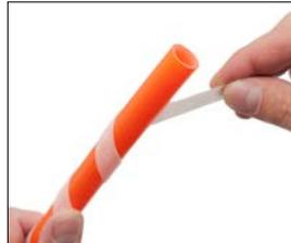
7 Zur Rohrmontage am REHAU Verteiler und zur Installation einer Schiebbehülsenverbindung ist das Hakenband ca. 5 cm vom Rohrende aus abzulösen.
