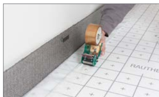
5. Den REHAU Randdämmstreifen mit der RAUTHERM SPEED Platte verkleben. Dafür ggf. den Folienfuß kürzen oder einschlagen.
