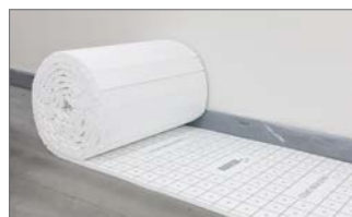
2. RAUTHERM SPEED Platte vom Randdämmstreifen aus verlegen. Zur vereinfachten Verlegung die Platte ohne längsseitigen Folienüberstand zum Raum hin verlegen.
