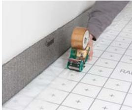
5 Den REHAU Randdämmstreifen mit der RAUTHERM SPEED Platte verkleben. Dafür ggf. den Folienfuß kürzen oder einschlagen.
