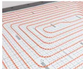
10 Nach bestandener Druckprobe (nach DIN EN 1264-4) ist das Klettsystem RAUTHERM SPEED bereit für die Aufnahme des Estrichs.
