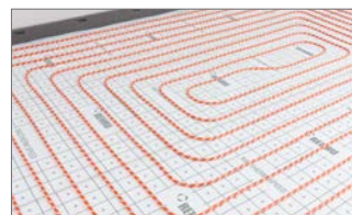
11. Nach bestandener Druckprobe (nach DIN EN 1264-4) ist das Klett-System RAUTHERM SPEED bereit für die Aufnahme des Estrichs.
