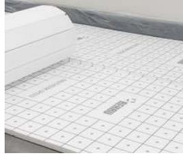
3 Längsseitiger Folienüberstand weiterer Platten überlappend installieren.
