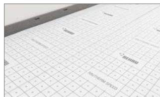
6. Alle Plattenlängs- oder Querkanten sowie der Randdämmstreifen sind verklebt und dichten gegen Estrichanmachwasser und Feuchtigkeit ab. Das Raster zeigt einen Verlegeabstand von 5 cm und Vielfachem.
