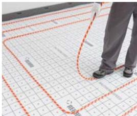
9 RAUTHERM SPEED K Rohre auf der RAUTHERM SPEED Platte durch leichtes Andrücken installieren.
