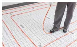
10. RAUTHERM SPEED K Röhre auf der RAUTHERM SPEED Platte durch leichtes Andrücken installieren.
