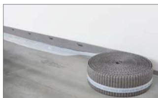
1. REHAU Randdämmstreifen befestigen.
