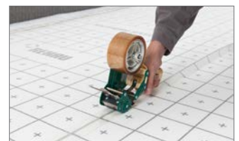
4. Alle Überlappungen der Plattenlängskanten und alle Querkanten mit REHAU Klebeband verkleben.
