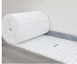
2 RAUTHERM SPEED Platte vom Randdämmstreifen aus verlegen. Zur vereinfachten Verlegung die Platte ohne längsseitigen Folienüberstand zum Raum hin verlegen.
