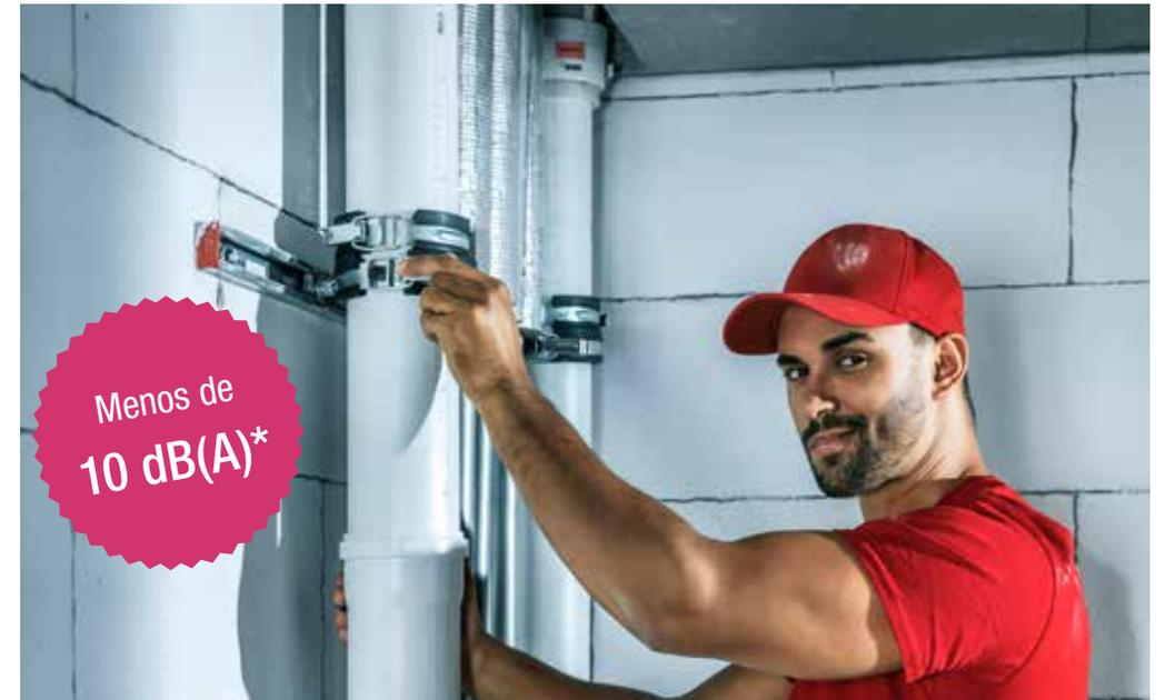
\*Valor obtenido para una descarga de 2l/s según UNE EN 14366. Montaje con abrazadera insonorizada REHAU patentada (P-BA 274/2016)
