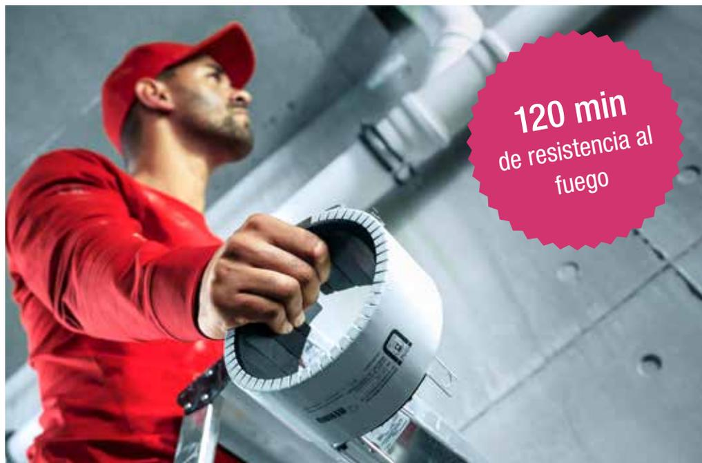
Todas las soluciones de REHAU para la protección contra incendios tienen una aprobación general como producto de construcción y cumplen la clase de resistencia al fuego según normativa. Además, combinando RAUPIANO PLUS con tubos para agua sanitaria y calefacción RAUTITAN se evita totalmente la laboriosa comprobación del cumplimiento de las distancias mínimas.
