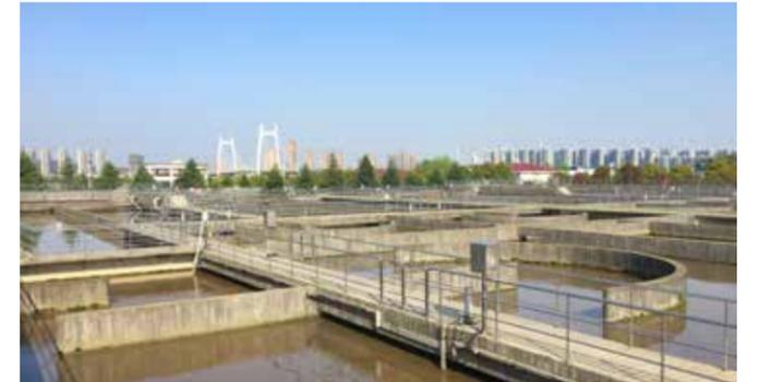
长沙市某污水处理厂项目一期处理水量30万吨/天，水质类型为市政污水。处理工艺采用改良的A/O工艺，出水达到国家一级B标准。曝气部分由四座相互独立、形式一样的生物池组成。七台风机四用三备，可根据需要提供400-700m<sup>3</sup>/min的风量。每座生物池的空气管道进口处有阀门调节气量。
