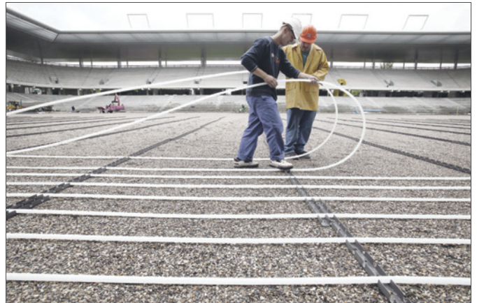
Kuva 12–3 Asenna lämmityspuutket
