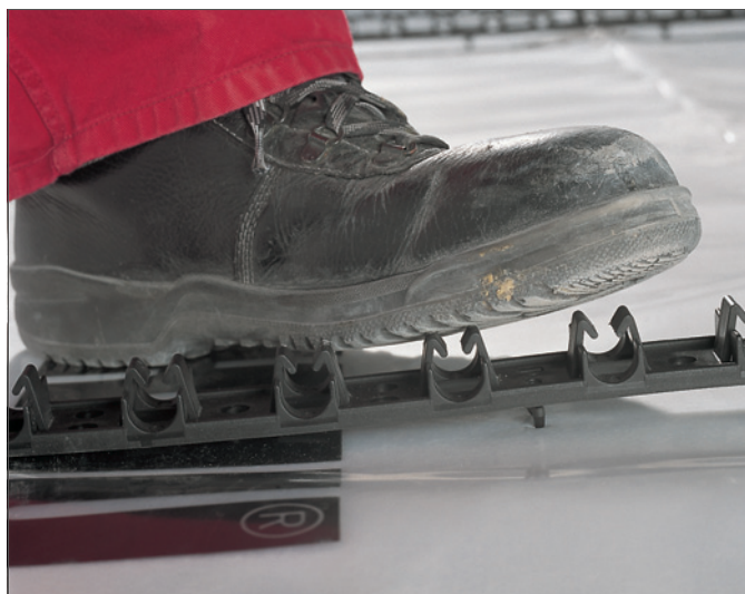
Kuva 3–37 Paina RAUFIX-kisko lattiarakenteeseen
