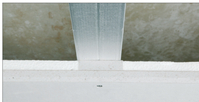
Kuva 4–6 Kattoelementtien kiinnitys
