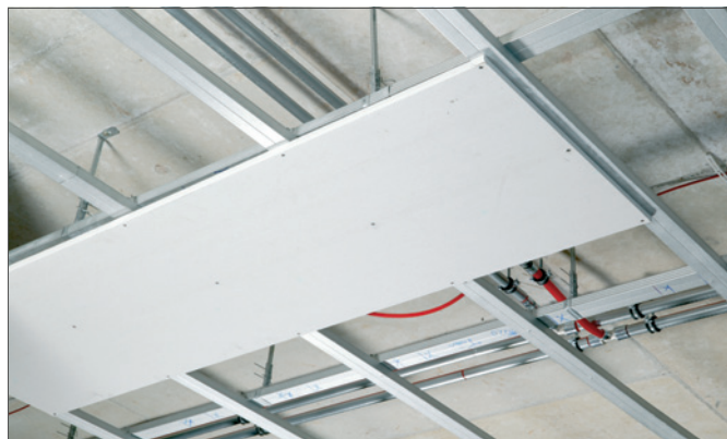
Kuva 4–34 Kattoon asennettu seinäelementti
