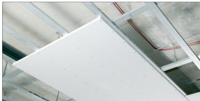
Kuva 4–5 Asennettu kattoelementti
