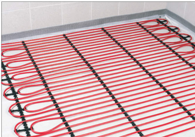
Kuva 3–82 Putkipidikelista tasoiteasennukseen
