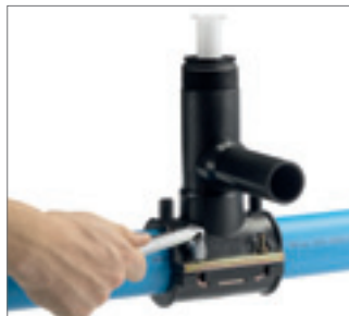
Рис. 56 4. Закрепить тройник под врезку
