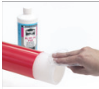
Рис. 95 Зона зачистки трубы должна быть очищена от пыли и обезжирена. Необходимо очистить данную зону достаточным количеством очистителя Tangit и дать полностью испариться
