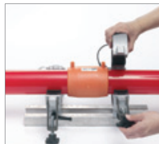
Рис. 106 После периода охлаждения, указанного на фитинге, можно демонтировать устройство для фиксации трубы
