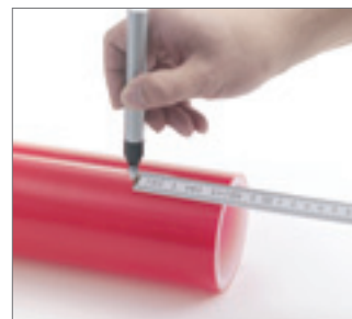
Рис. 91 Отметить область зачистки трубы в соответствии со следующими таблицами. Рекомендовано использовать маркер в отличной от трубы цветовой гамме
