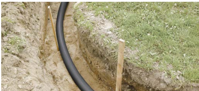
Fig. 49 Lægning af rør i bøjet område
