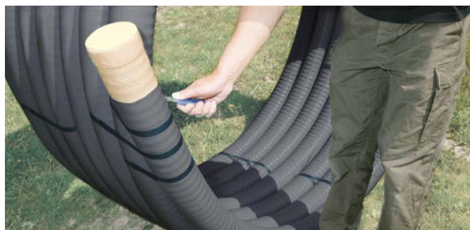
Fig. 46 Opskæring af strips
