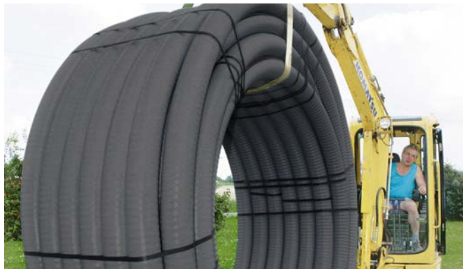
Fig. 42 Løft med gravemaskine
