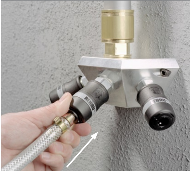
Abb. 4: Schlauchabschnitt entlüften
