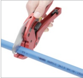
Abb. 27: 1. Rohr mit Rohrschere rechtwinklig und gratfrei auf das gewünschte Maß ablängen
