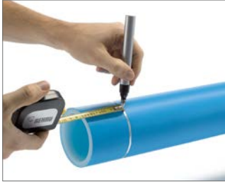
Abb. 65 Zum Anzeichnen PE-Stift in Kontrastfarbe verwenden.
