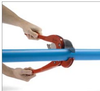
Abb. 39 1. Rohr rechtwinklig und gratfrei auf das gewünschte Maß ablängen.
