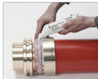
Abb. 32 7. Rohr im Verbindungsbereich am kompletten Umfang gleichmäßig mit Gleitmittel von REHAU benetzen.
