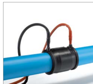
Abb. 49 11. Ausrichtung und Einstecktiefe überprüfen. Schweißung muss spannungsfrei erfolgen. Ggf. sind Rundrückklemmen oder Rohrhalteklappen einzusetzen.
