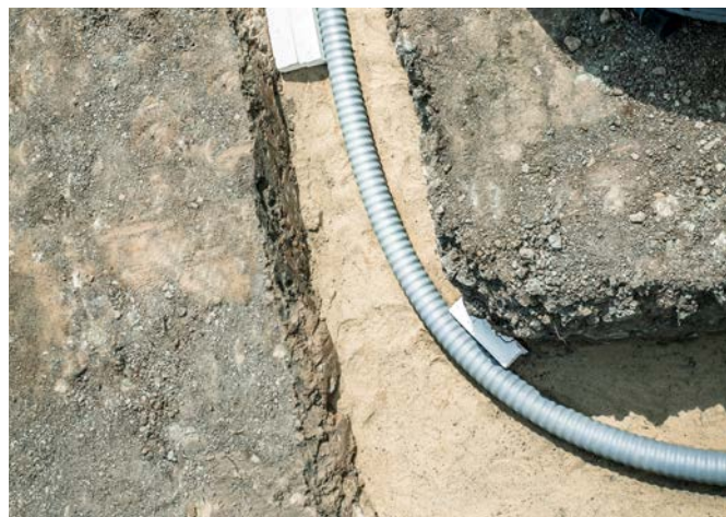
Rys. 15 Rura preizolowana RAUTHERMEX z izolacją zespoloną
