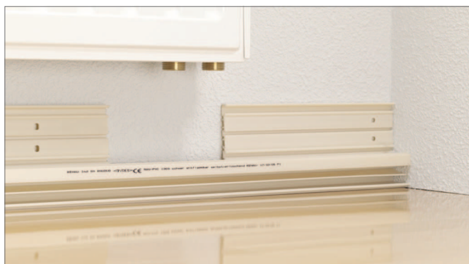
Fig. 16-22 Installerad RAUDUO sockelkanalunderdel med utskärning
