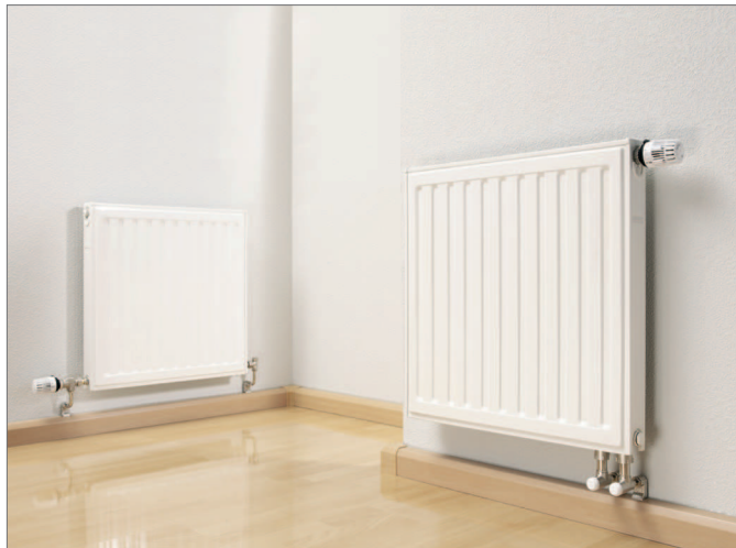
Fig. 16-1 Radiatoranslutningssystem golvsockel
