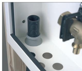
Fig. 5-16 Sätt in skyddsrör - min. 6 cm
