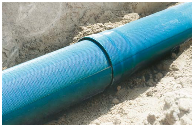
Sl. 13-2 Polaganje drenaže na terenu
