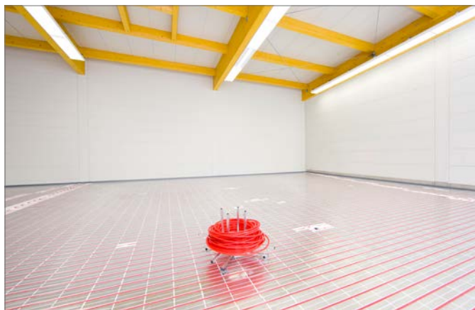
Sl. 11-1 Sistem suve gradnje sa površinsko-elastičnim sportskim podom
