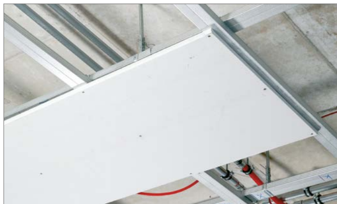
Sl. 5-36 Montiran zidni element na plafonu
