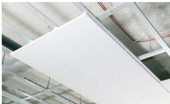
Sl. 5-5 Montiran plafonski element
