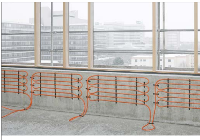
Sl. 5-16 REHAU zidno grejanje/hlađenje u mokroj gradnji
