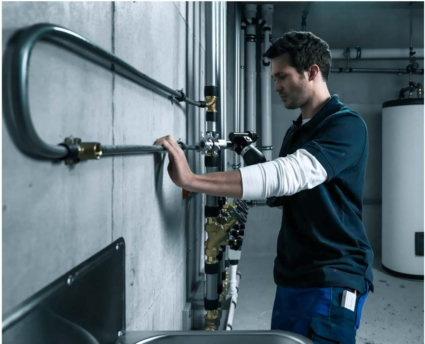
Preduslov za takve sisteme su komponente koje imaju veoma mali hidraulički otpor. REHAU nudi kompletan assortiman takvih optimizovanih komponenti, koje su specijalno namenjene prstenastim
