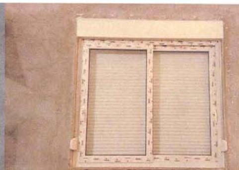
Foto 6: Vista da persiana fechada – lado interno
