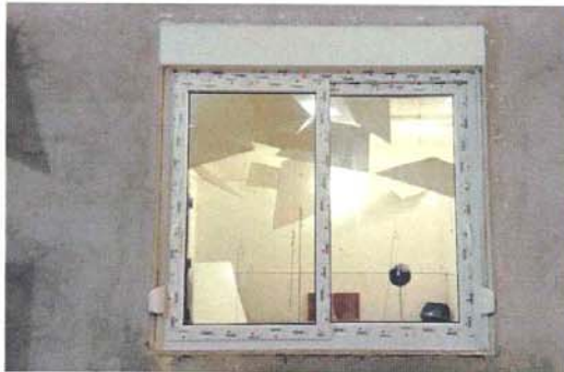
Foto 5: Vista da persiana aberta – lado interno
