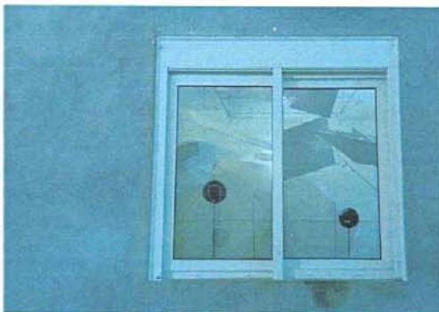
Foto 3: Vista da persiana aberta – lado externo
