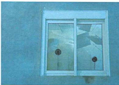
Foto 3: Vista da persiana aberta – lado externo
