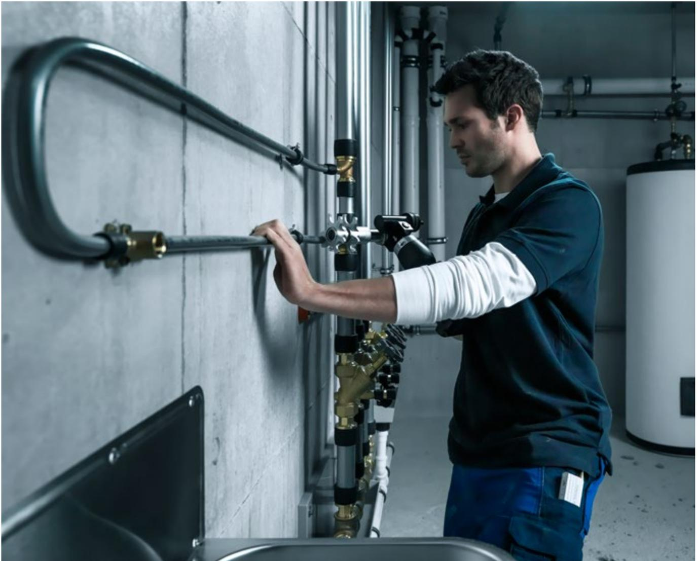
Voraussetzung für solche Systeme sind Bauteile, die einen besonders geringen Strömungswiderstand haben. REHAU bietet ein komplettes Sortiment solcher strömungsoptimierter Bauteile, das speziell
