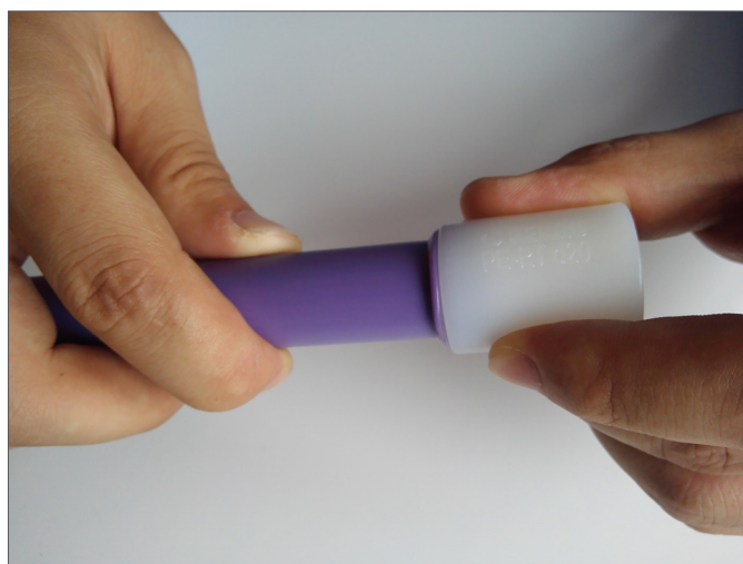
图 8-11 连接管道和管件
