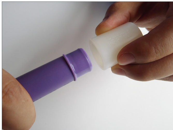
图 8-10 对准管道和管件
