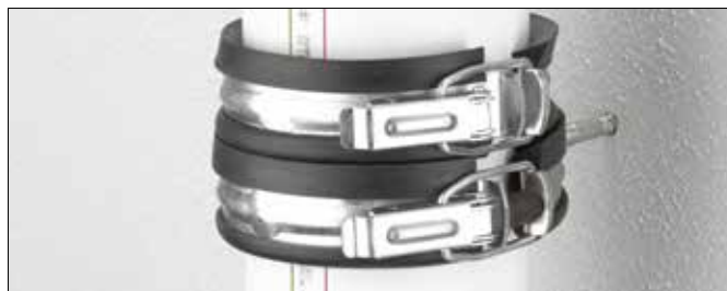
图 3-8 正确安装双层降噪支架
