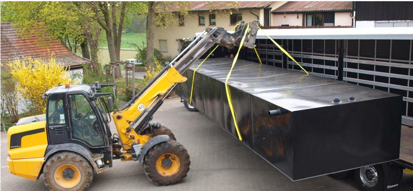
Bei kleineren Anlagen kommen Speichermodule aus mit Kunststoffplatten ummantelten RAUSIKKO Boxen zum Einsatz. Das werkseitig vorgefertigte Modul ist innerhalb kürzester Zeit geplant, wird anschlussfertig geliefert und ist im Nu verbaut. Der Anschluss erfolgt durch das Tiefbauunternehmen. Eine bauseitige Verschweißung ist nicht mehr erforderlich.
