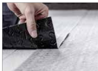
Sovrapposizione minima di 5 cm sul bordo longitudinale
