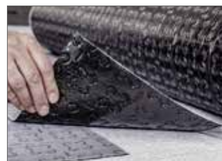
Sovrapposizione minima di 10 cm sul bordo trasversale
